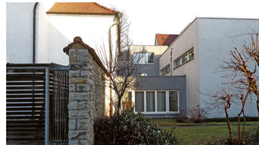
Südfassade der Kirche und rechts das Kirchgemeindehaus mit dem später angebauten Sitzungszimmer und dem darüber realisierten Sekretariatsbüro.
