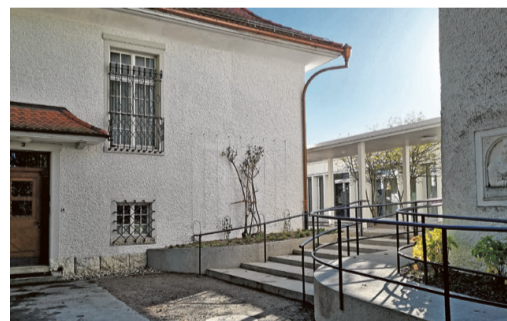
Die neue Treppe und die behindertengerechte neue Rampe führen zum Innenhof des Kirchgemeindehauses.
