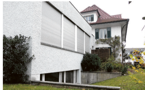
Südfassade des Saals und des halbhunterirdischen Gruppenraums.
