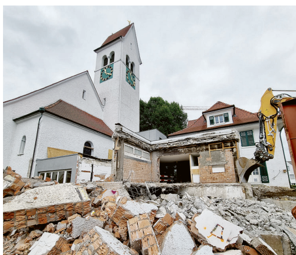
Am Nachmittag des 28. August sind vom alten Kirchgemeindehaus nur noch ein paar Trümmer übrig.
