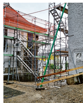
Am 25. September ist das Foyer zwischen Pfarrhaus (links) und Kirche entfernt und gibt den Blick in die Baugrube frei. | FOTOS C. MARTI
