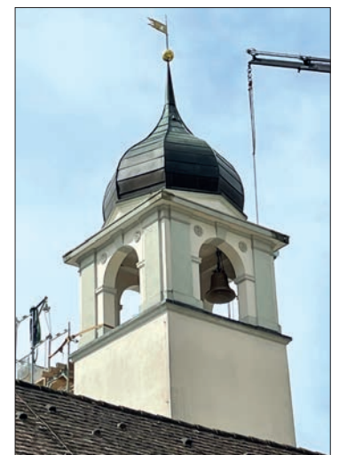
Eine der Glocken hängt bereits im Kirchturm.
