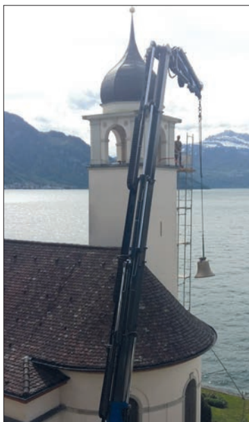
Mit dem Spezialkran werden die Glocken in den Kirchturm gehievt, der Monteur auf der Plattform erwartet sie bereits.
