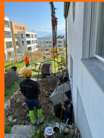
Einbringen des Lichtschachts
